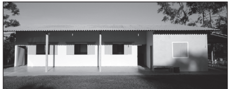
Obra concluída - Refeitório Aldeia Taquapery
