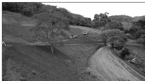
3º Platô (em construção)
