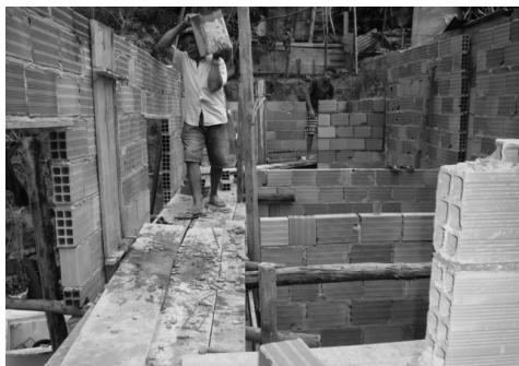
Início obra Bairro S. Teresinha - Pedreiro Moca
