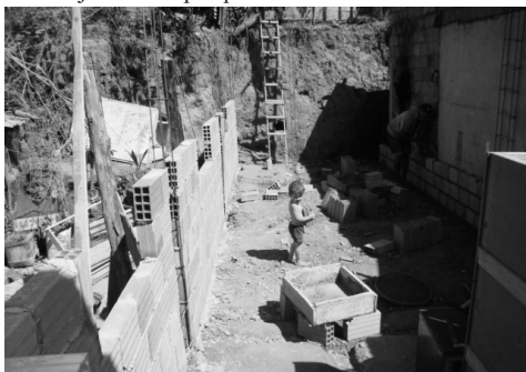
Início obra Bairro S. Teresinha - Casa Sebastião e Denise
