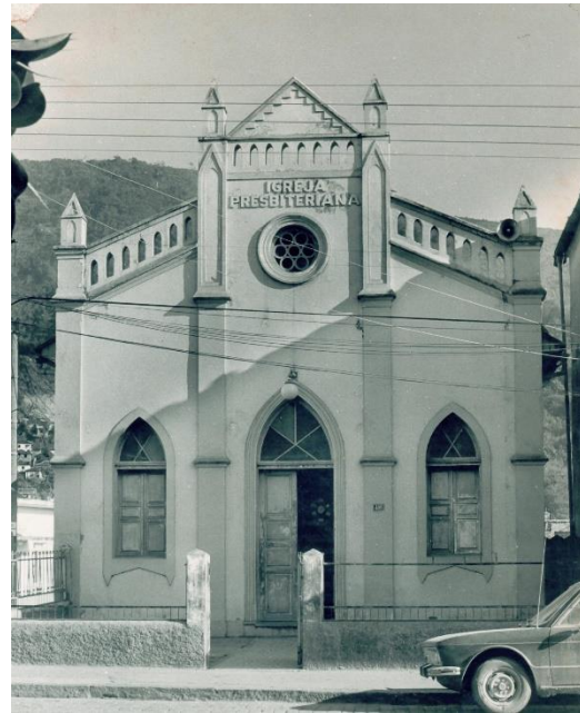
Segundo Templo remodelado
