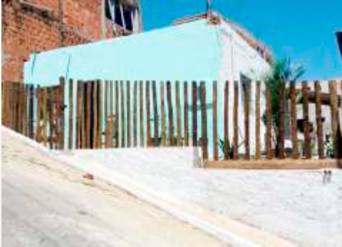
Vista externa da casa
