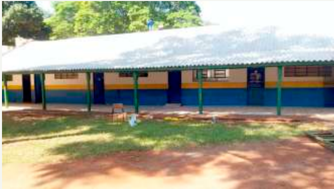
Escola Indígena com o novo telhado
