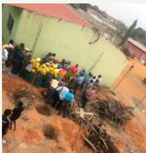
Lançamento Pedra Fundamental
