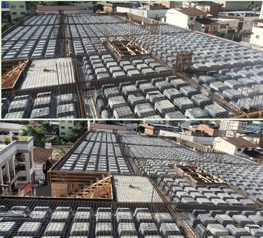
Nesta semana (02/12 a 06/12/24), foi possível fazer a fixação final dos painéis de madeira em torno de toda área construída, bem como a colocação da malha sobre as cubetas e fixação nas ferragens.
