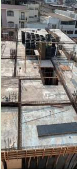
Nesta semana (02/09 a 06/09) os trabalhadores deram sequência aos serviços de preparação para a segunda laje do Edifício. Após o afastamento da rede elétrica, foi possível concretar o pilar próximo a mesma e dar sequência à obra
