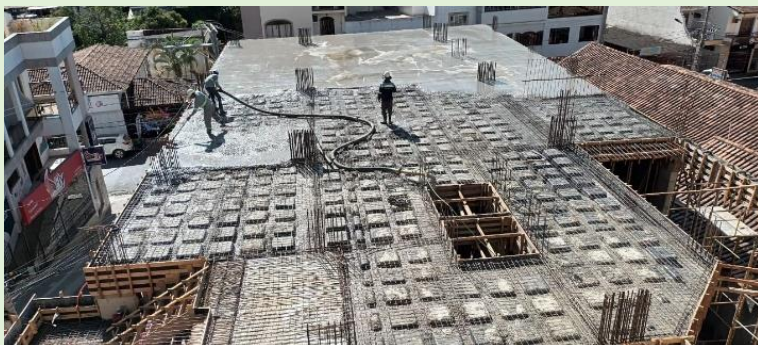
Seqüência da Concretagem
