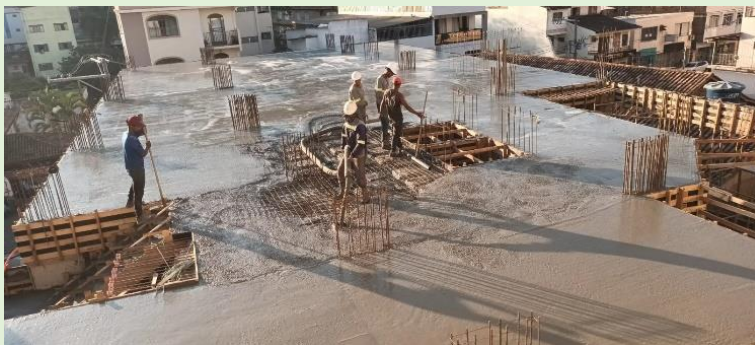
Finalizando a Concretagem
