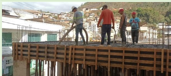
Início da Concretagem
