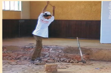
Início da demolição - Janeiro 2005
